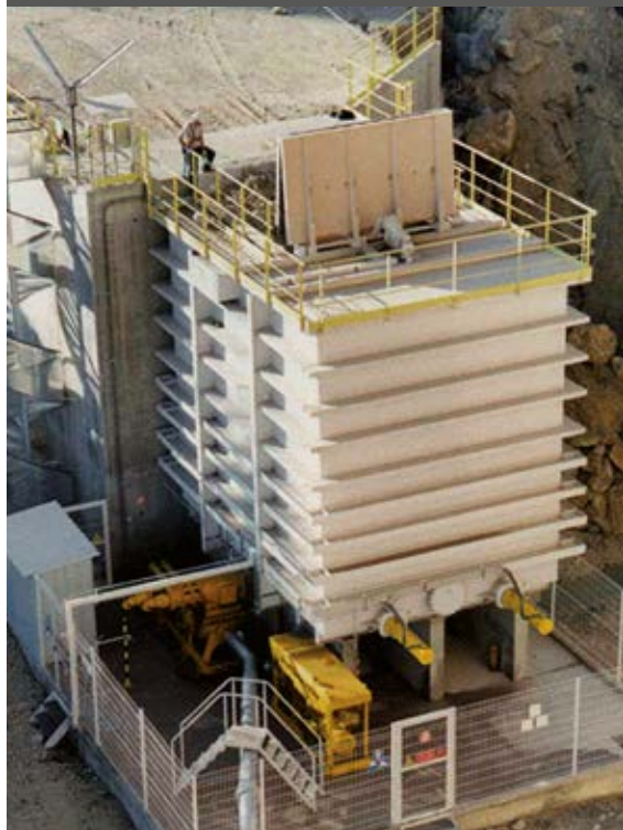
Le Teil Lafarge, France
