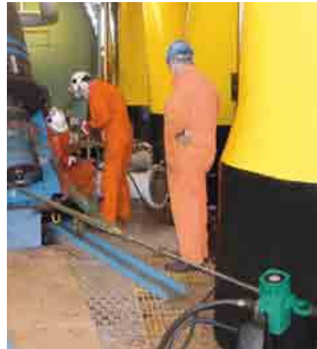
JDN air hoist mini 1000 handling an oil pump.
